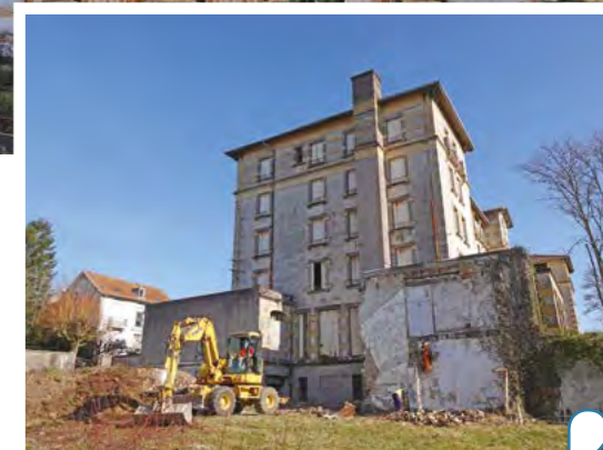
En activité, l'hôtel comptait différents espaces : hall d'accueil, salons, salle de restaurant, sanitaires, chambres (une centaine) et combles.
