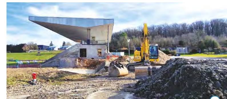
2023 : travaux d'étanchéité, d'isolation, de mise aux normes des installations électriques, sanitaires, etc.
